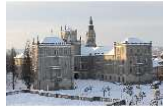
CoE.I, Hauptfassade mit Schnee im Winter, DI009712, BSV-
