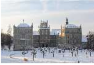
CoE.I, Hauptfassade mit Schnee im Winter, DI009701, BSV-
