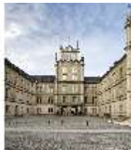
CoE.I, Hauptfassade und Ehrenhof, DI009197, BSV-
