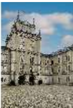
CoE.I, Hauptfassade mit Turm, DI020873, BSV-
