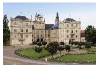
CoE.I, Schlossplatz und Hauptfassade, DI009204, BSV-
