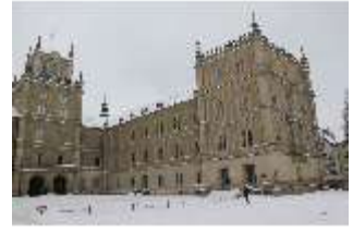
CoE.I, Hauptfassade mit Schnee im Winter, DI009704, BSV-
