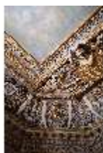
CoE.II, Thronsaal, R. 13, Deckendetail: Hohlkehle, DI024992, BSV-
