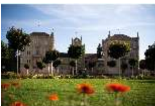
CoE.I, Schlossplatz mit Hauptfassade, DI024937, BSV-
