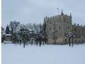
CoE.I, Hauptfassade mit Schnee im Winter, DI009709, BSV-
