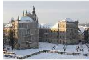
CoE.I, Hauptfassade mit Schnee im Winter, DI009711, BSV-
