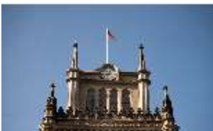
CoE.I, Hauptfassade, Turm mit Uhr, DI025118, BSV-
