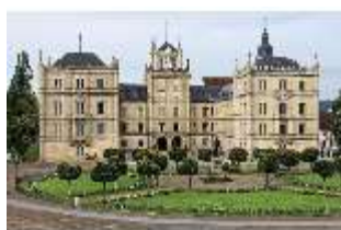
CoE.I, Schlossplatz und Hauptfassade, DI009200, BSV-
