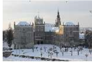
CoE.I, Hauptfassade mit Schnee im Winter, DI009703, BSV-
