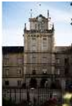
CoE.I, Hauptfassade (mittlerer Trakt) des Schlosses, DI024932, BSV-
