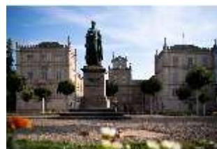
CoE.I, Schlossplatz mit Hauptfassade, DI024935, BSV-
