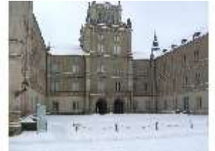
CoE.I, Hauptfassade mit Schnee im Winter, DI009708, BSV-
