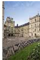
CoE.I, Hauptfassade und Ehrenhof, DI009198, BSV-
