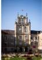
CoE.I, Hauptfassade, mittlerer Trakt, Turm, DI025113, BSV-
