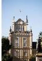
CoE.I, Hauptfassade, mittlerer Trakt, Turm, DI025116, BSV-
