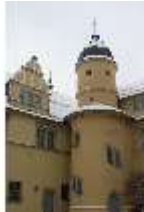
CoE.I, Hauptfassade mit Schnee im Winter, DI009706, BSV-
