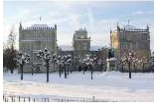
CoE.I, Hauptfassade mit Schnee im Winter, DI009702, BSV-
