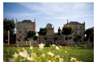
CoE.I, Schlossplatz mit Hauptfassade, DI024936, BSV-
