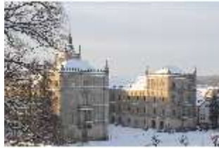
CoE.I, Hauptfassade mit Schnee im Winter, DI009710, BSV-
